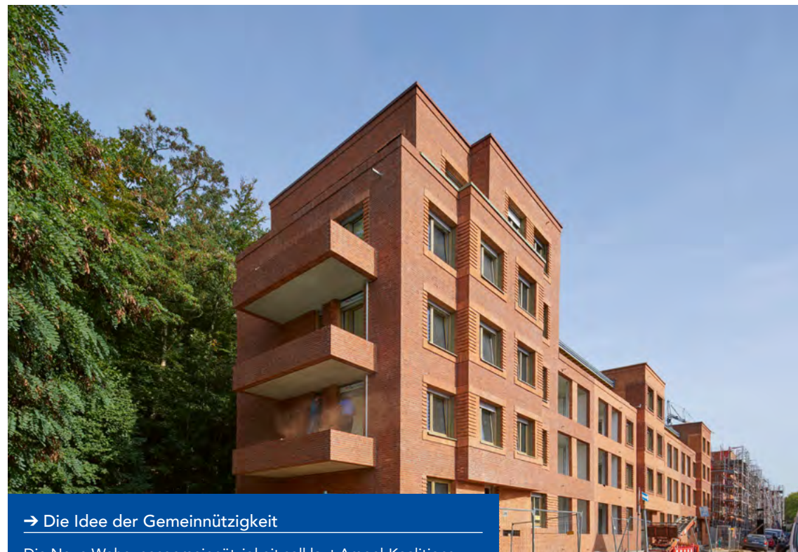
„Die Passage“ ist eines der aktuellen Projekte der Wohnungsgenossenschaft Düsseldorf-Ost (WOGEDO). An der Hagener und an der Lüdenscheider Straße in Gerresheim werden Bestandshäuser ersetzt und 187 moderne Wohnungen für Mitglieder der Genossenschaft errichtet.
